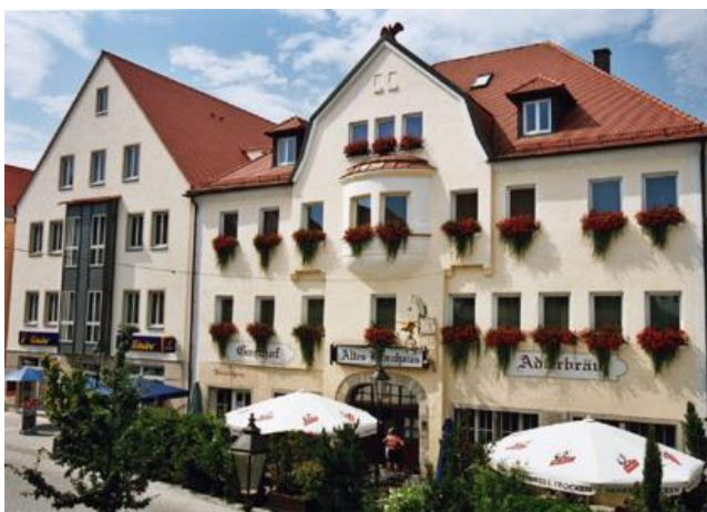
Gasthof Adlerbräu / Gunzenhausen
